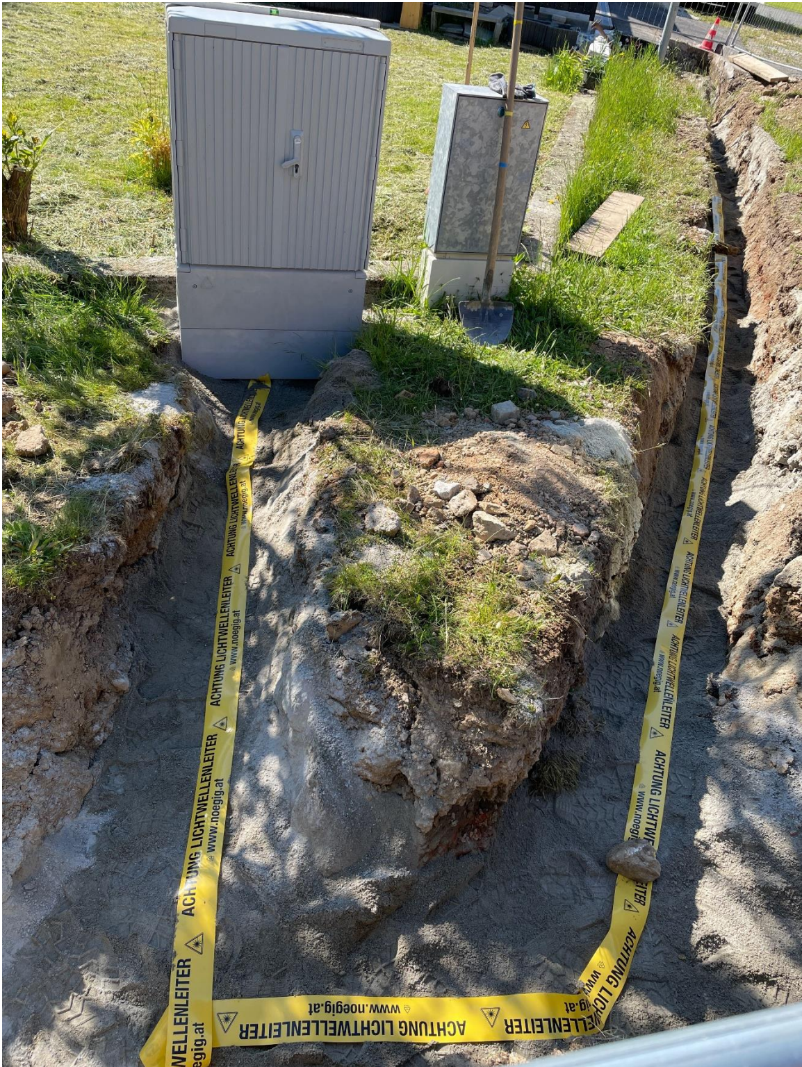
Abbildung 2: Zuleitung zu FCP; Verfüllarbeiten mit Warnband, Gemeinde Waidhofen an der Thaya
