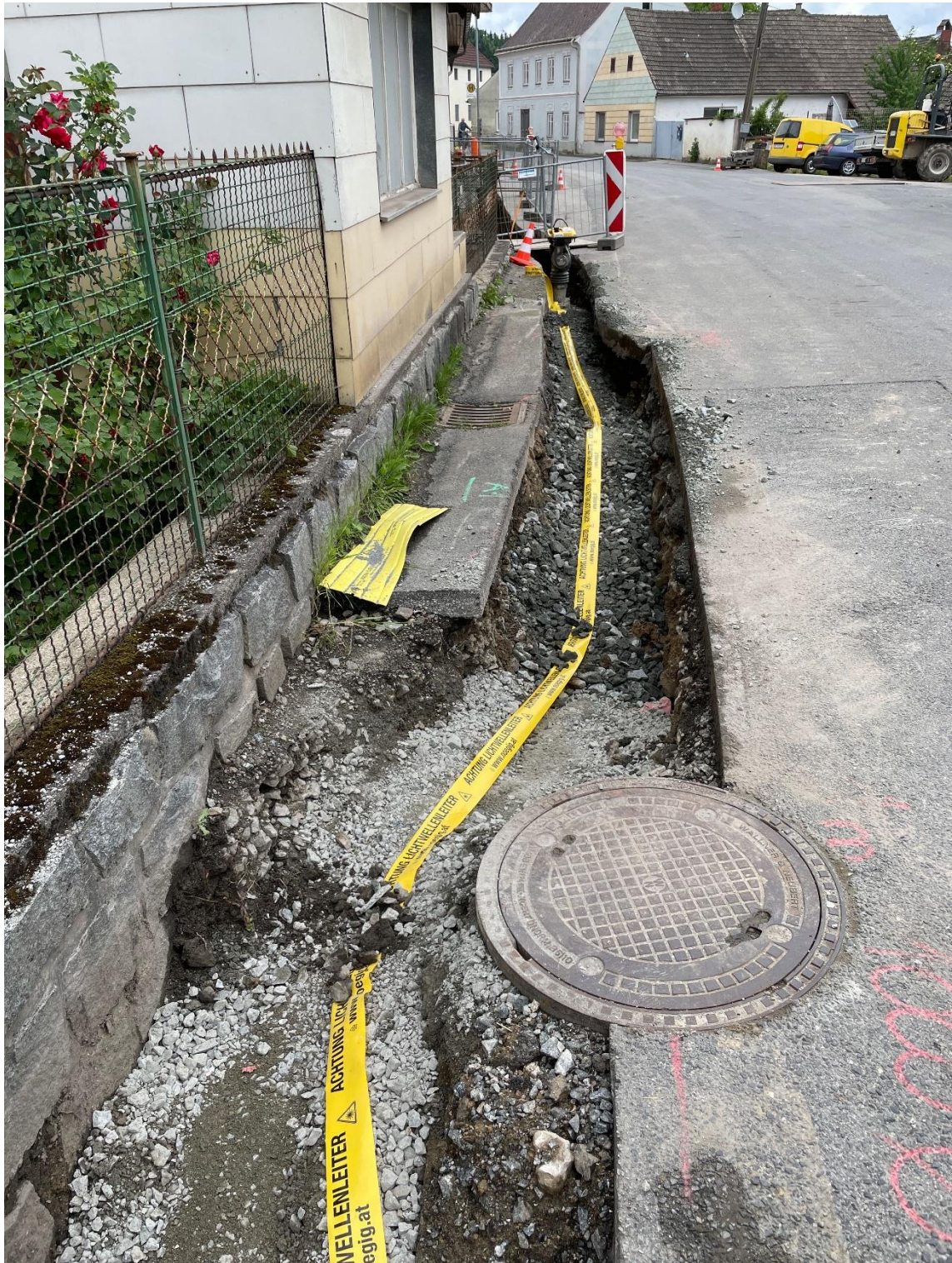
Abbildung 1: unbefestigte Künette, Verfüllarbeiten mit Warnband, Gemeinde Waidhofen an der Thaya
