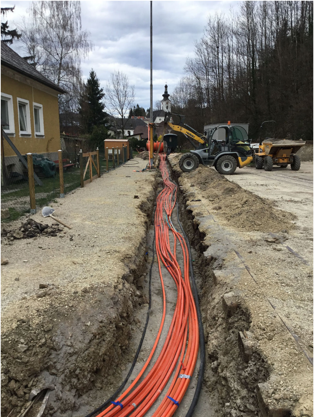
Abbildung 2: Verlegung einer Vielzahl an MRV ausgehend von der Ortszentrale in Ybbsitz
