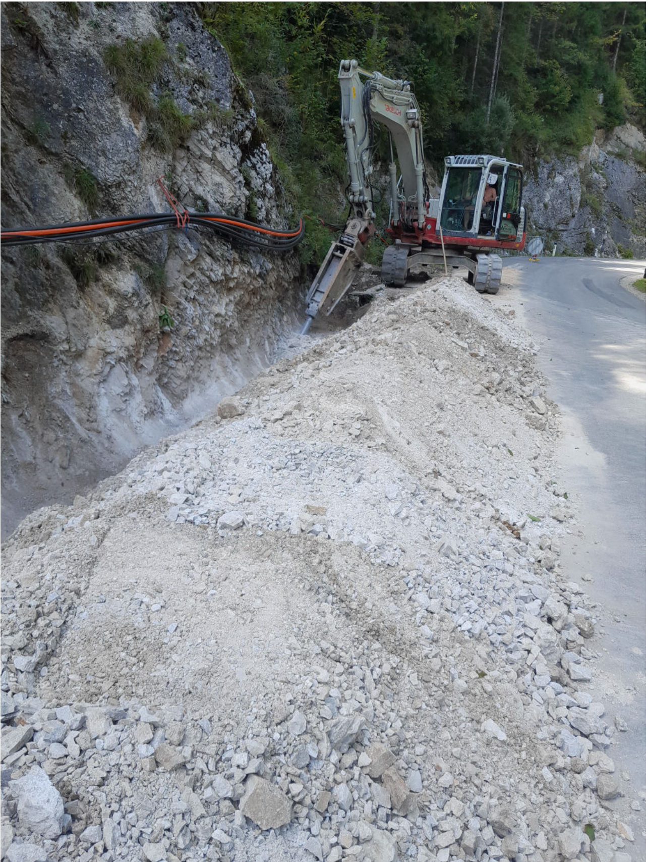
Abbildung 4: Verlegung von MRVs in felsigem Gelände; Gemeinde Lunz am See
