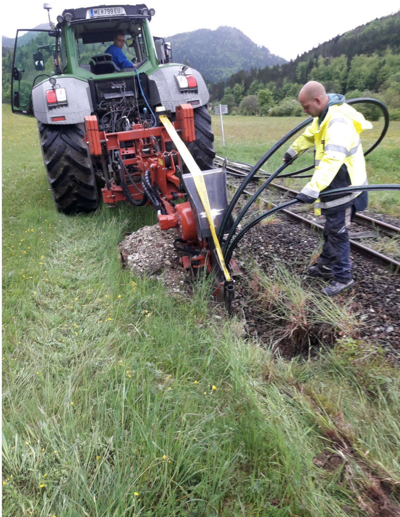
Abbildung 5: Verlegung mittels Kabelflug entlang einer Bahntrasse in Göstling a.d. Ybbs
