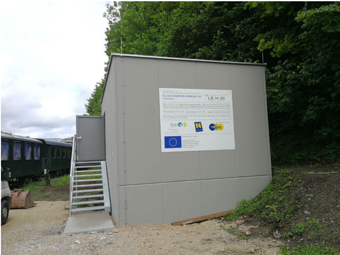
Abbildung 1: Ortszentrale in der Gemeinde Ybbsitz mit angebrachter Hinweistafel zum ELER Förderprojekt
